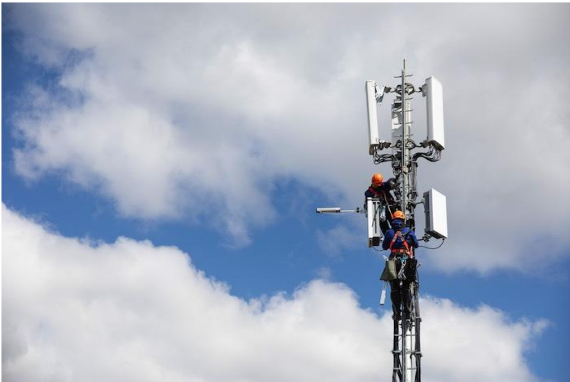
Installationsfachmänner bei der Arbeit. Foto: Keystone, Peter Klaunzer
