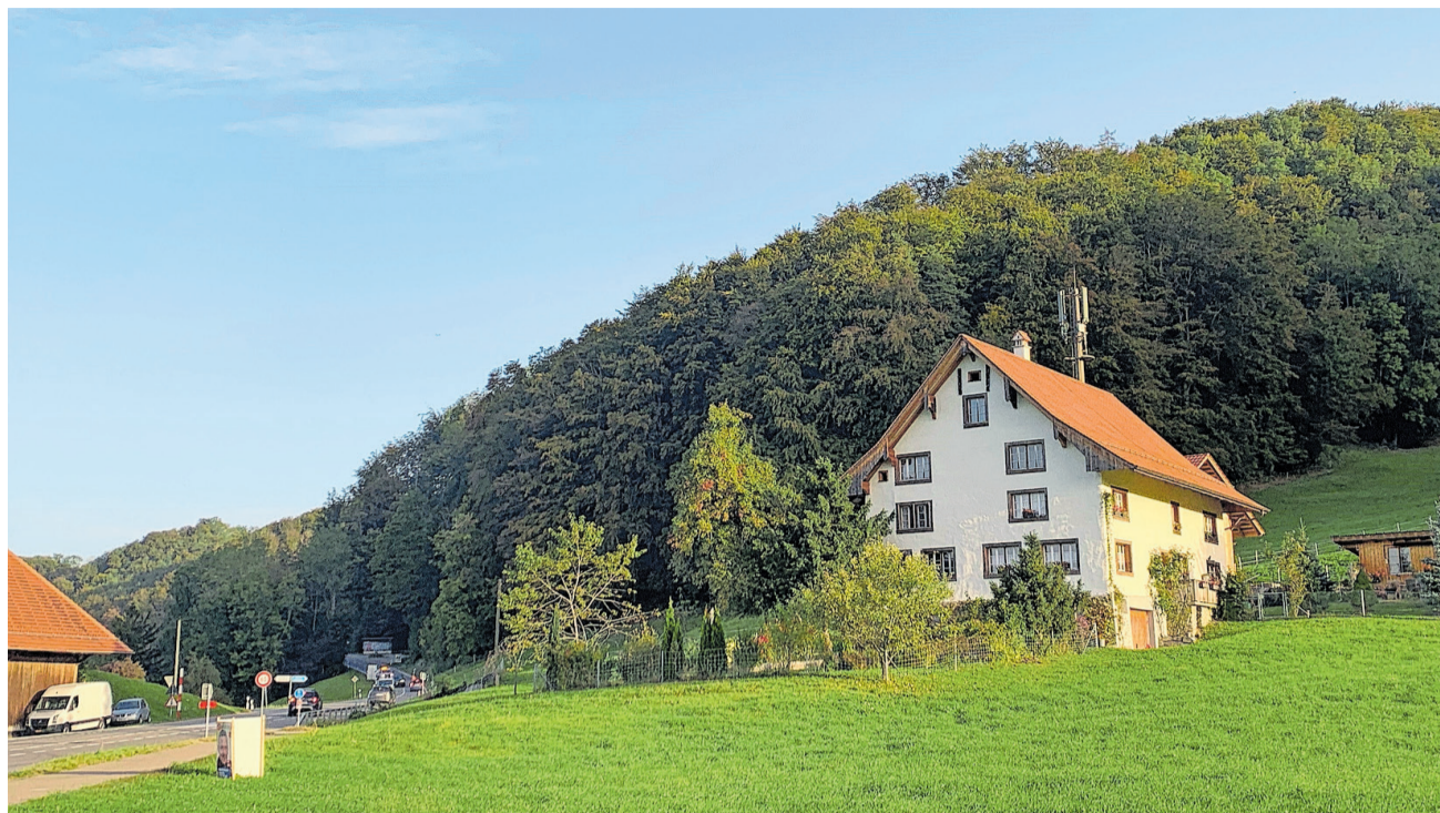
Die bestehende Antenne in der Riedmatt soll auf die 5G-Technologie aufgerüstet werden. (Bild Livia Häberling)
